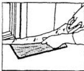
Рис. 8. Подрезка нижней части дверной коробки
